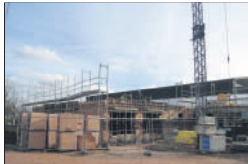
Der Anbau an die Turnhalle macht Fortschritte. Die Schüler sollen hier Räume für Werken, Musik und Theater bekommen. Hemme
